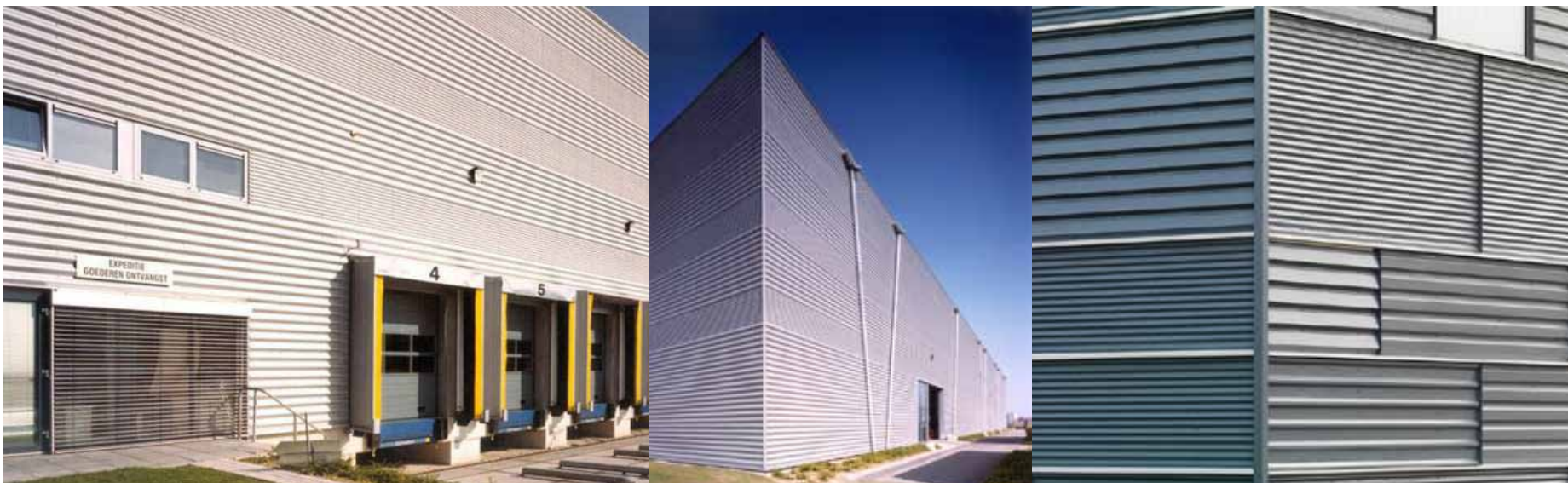
bedrijfshallen: diversiteit grijs tinten en structuren toegestaan
